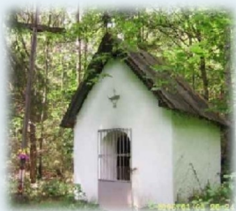
zdj. 2. Kapliczka przed remontem
