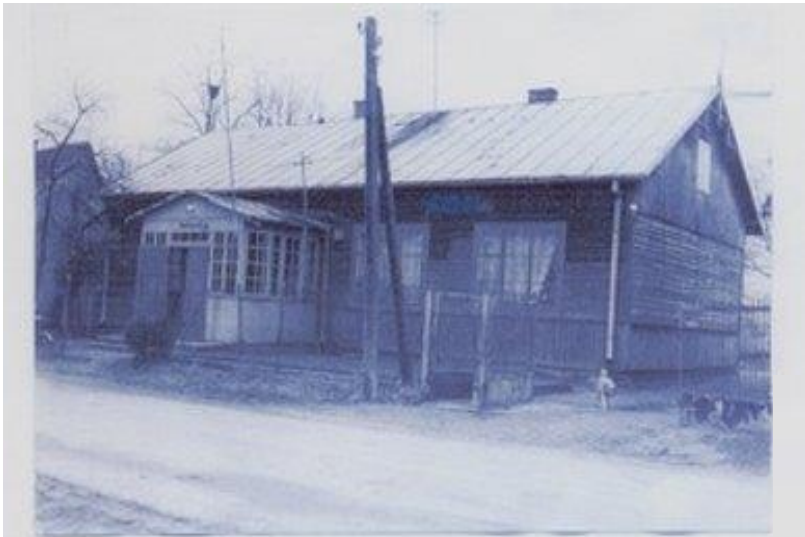
Drugi budynek szkolny oddany do użytku w 1948 r.
