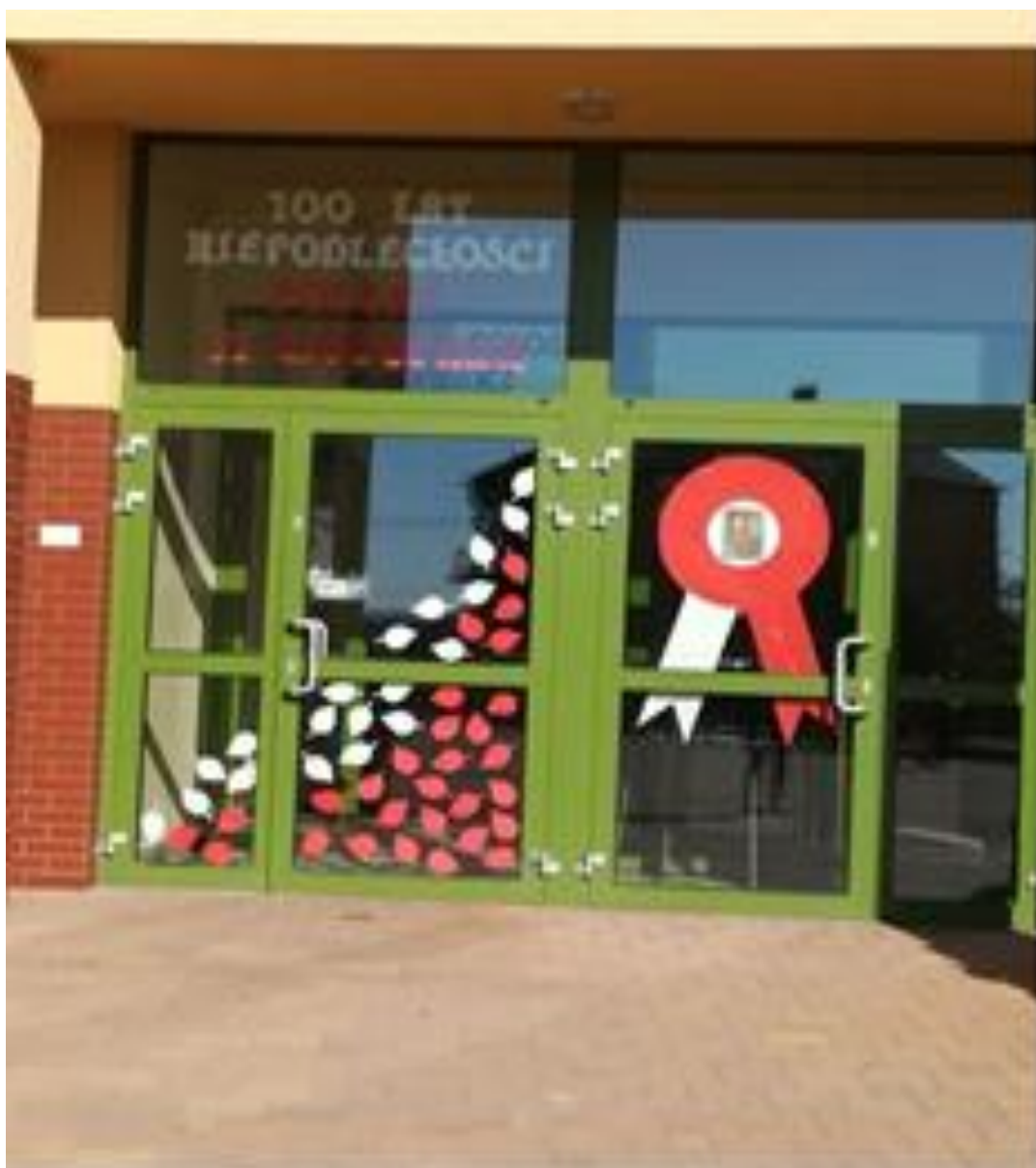
Fot. 7. Wejście główne do budynku szkoły.
