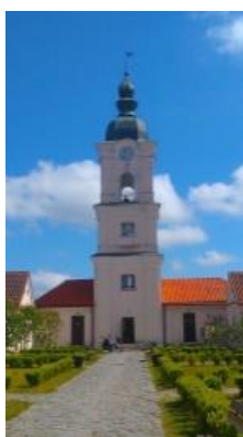
Wieża zegarowa przy klasztorze
