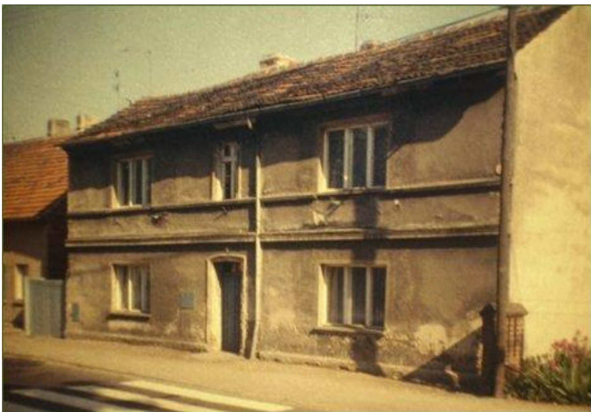
Dawny budynek SG w Masłowie (stan obecny)
