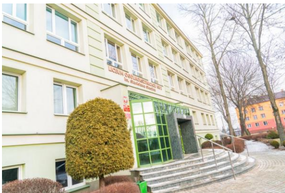
Zdjęcie budynku szkoły
