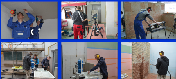
Uczniowie wykonujący prace wykończeniowe podczas praktyk zawodowych
