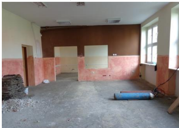
PIERWSZY MIESIĄC REMONTU ZA NAMI
