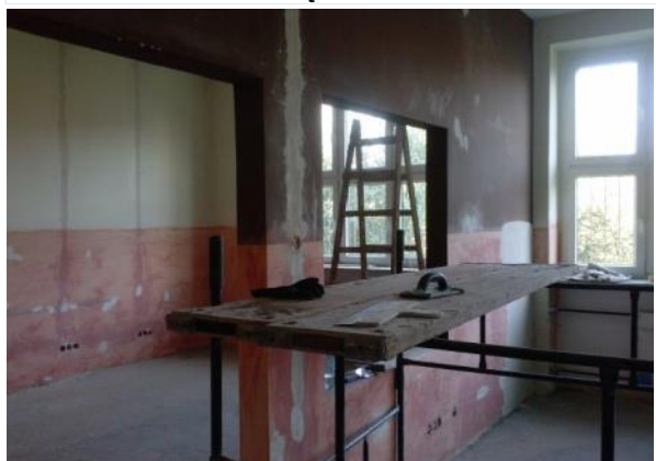
WRZESIEŃ - REMONT SIĘ ROZPOCZYNA
