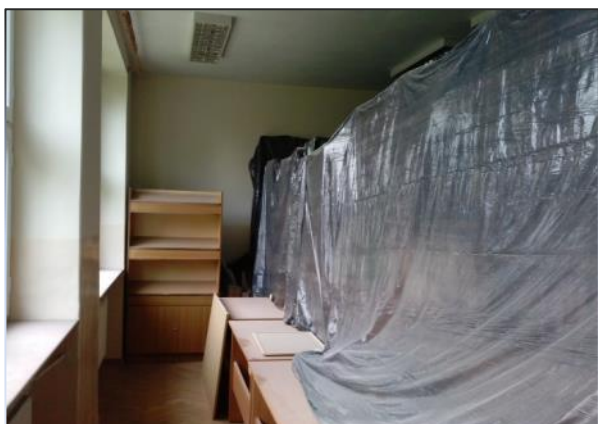
CZERWIEC - CHRONIMY KSIĘGOZBIÓR PRZED KURZEM
