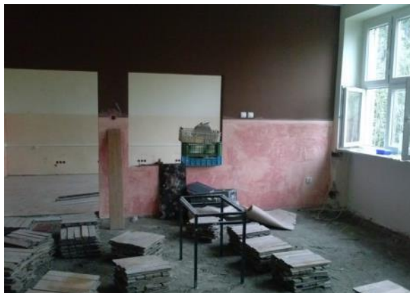
WYMIANA INSTALACJI, OGRZEWANIA I ZRYWANIE PODŁÓG
