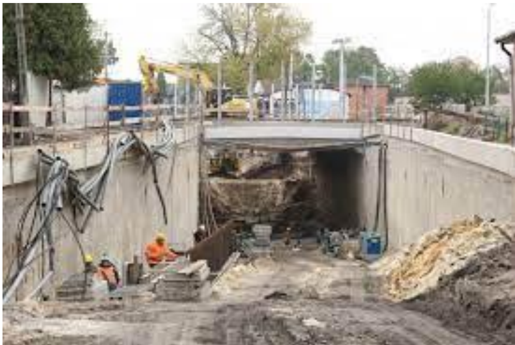
w trakcie budowy
