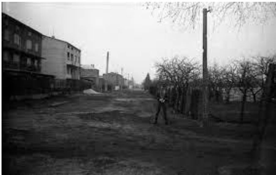
Budynek szkoły postawiono na terenie ogródków działkowych.
