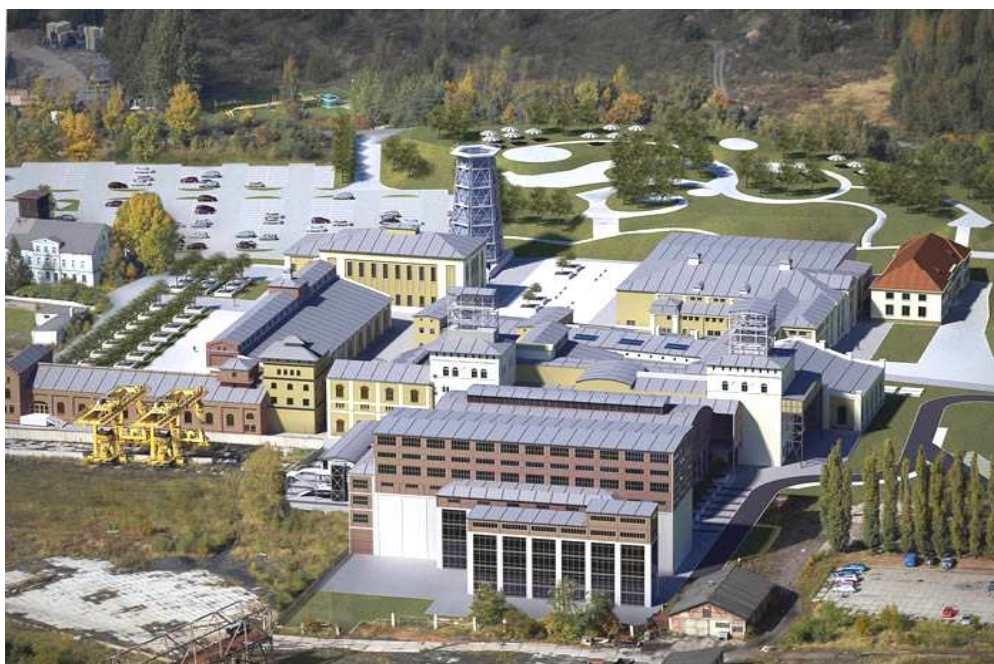
TAK BĘDZIE WYGLĄDAĆ PARK WIELOKULTUROWY STARA KOPALNIA PO REMONCIE
